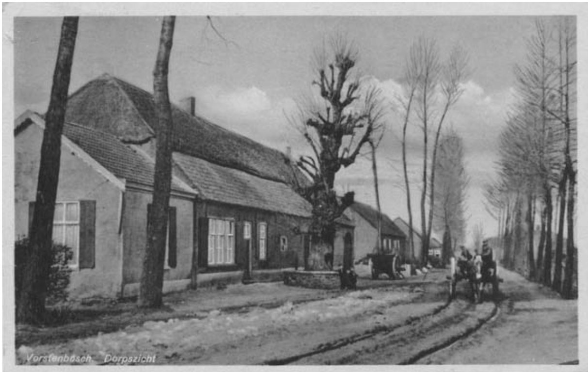
De aanbouw aan de boerderij fungeerde jarenlang als herberg.
